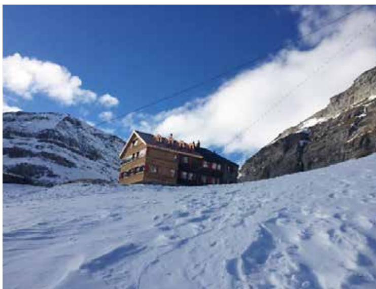
Erweiterungsbau SAC Lämmerenhütte: kein anderer Baustoff hätte die Anforderungen für dieses Bauwerk erfüllt.
