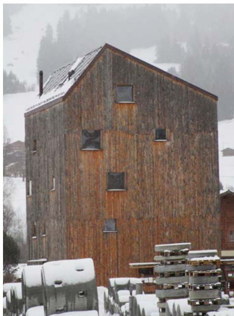
Wohn- und Gewerbehaus Holz100 Zweisimmen
